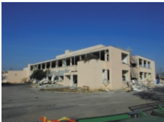
AZF社西側の道路を挟んで門の向かい側にある別の会社の建物の被害状況
