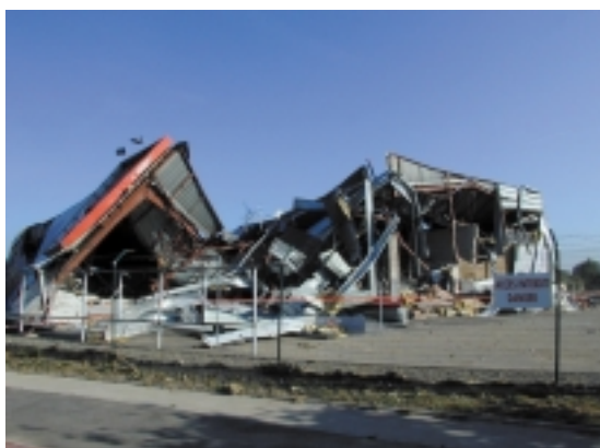
AZF社西側道路を北上したところにある家電販売店の被害状況
